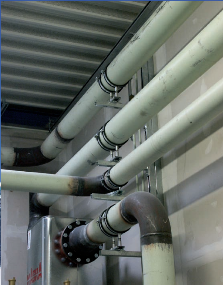
Produktionsanlage Härterei Montageschienen System 45 mit Konsolen
