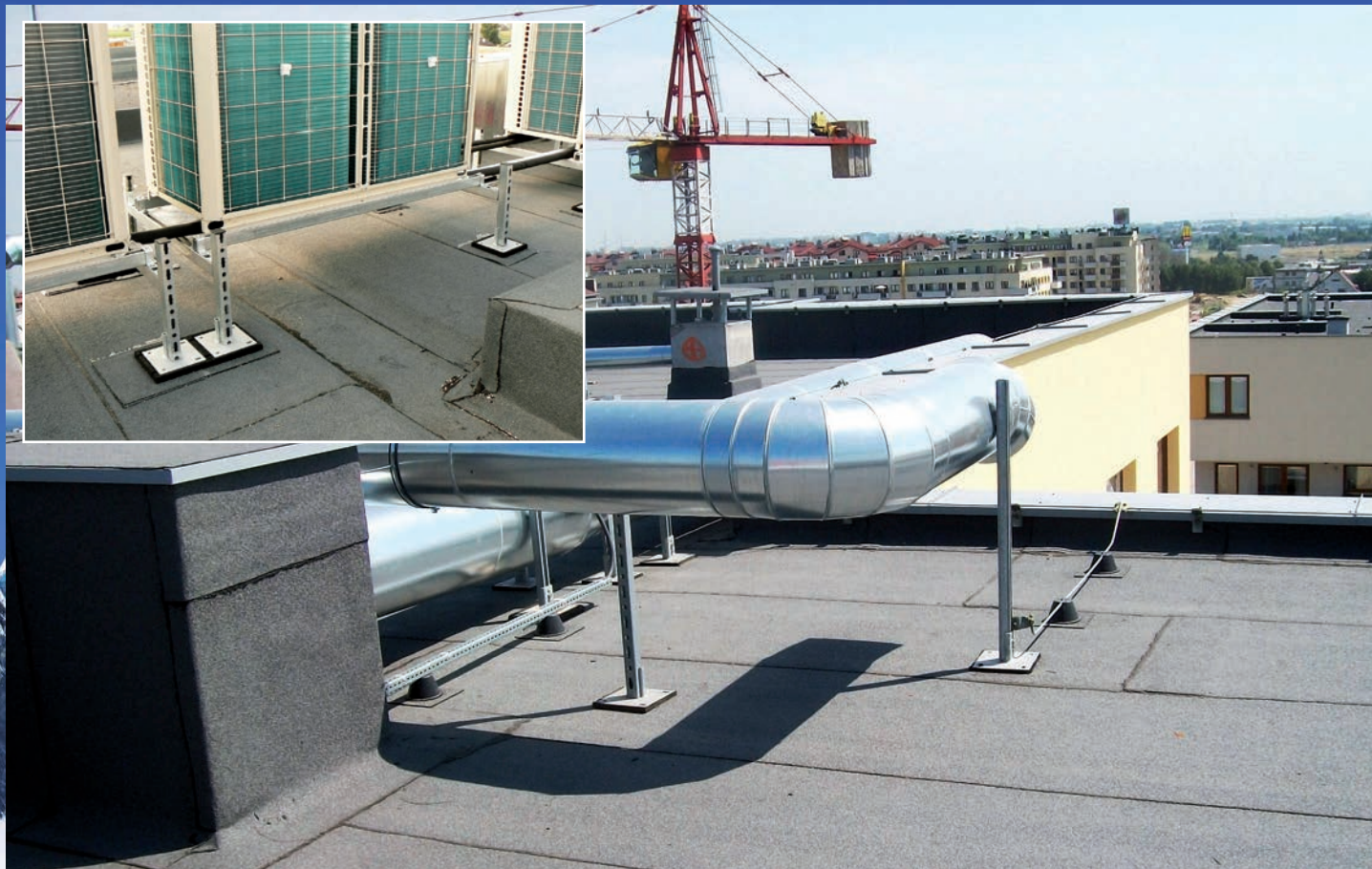
Lüftungssysteme auf Flachdächern Montageschienen System 45 mit Dachhalter für Flachdachkonstruktionen
