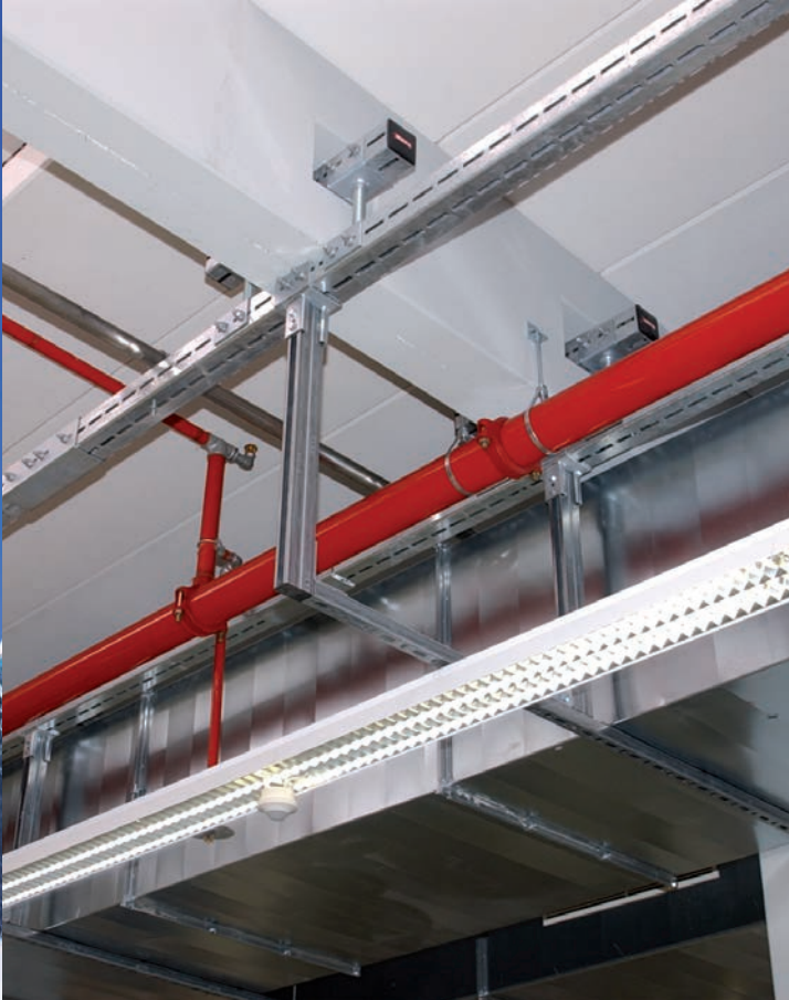
Versorgungstrasse für Produktionsanlage an Betonunterzüge Montageprofil CENTUM® XL 100 mit Montageschienen System 45
