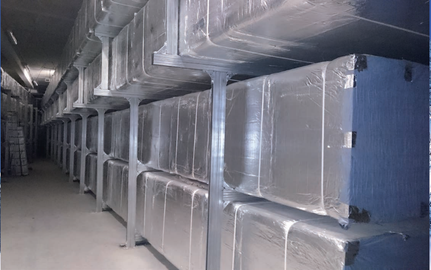
Lüftungssystem Montageschienen System 45 mit Anbauteilen
