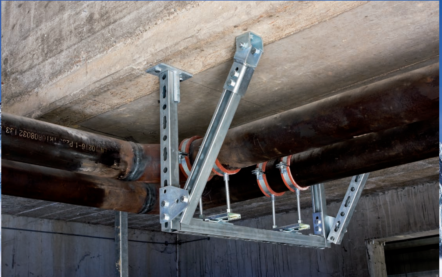
Befestigung warmgehende Leitung, Stahl Gleiter GL 200 mit Lasche auf Montageschienen System 45
