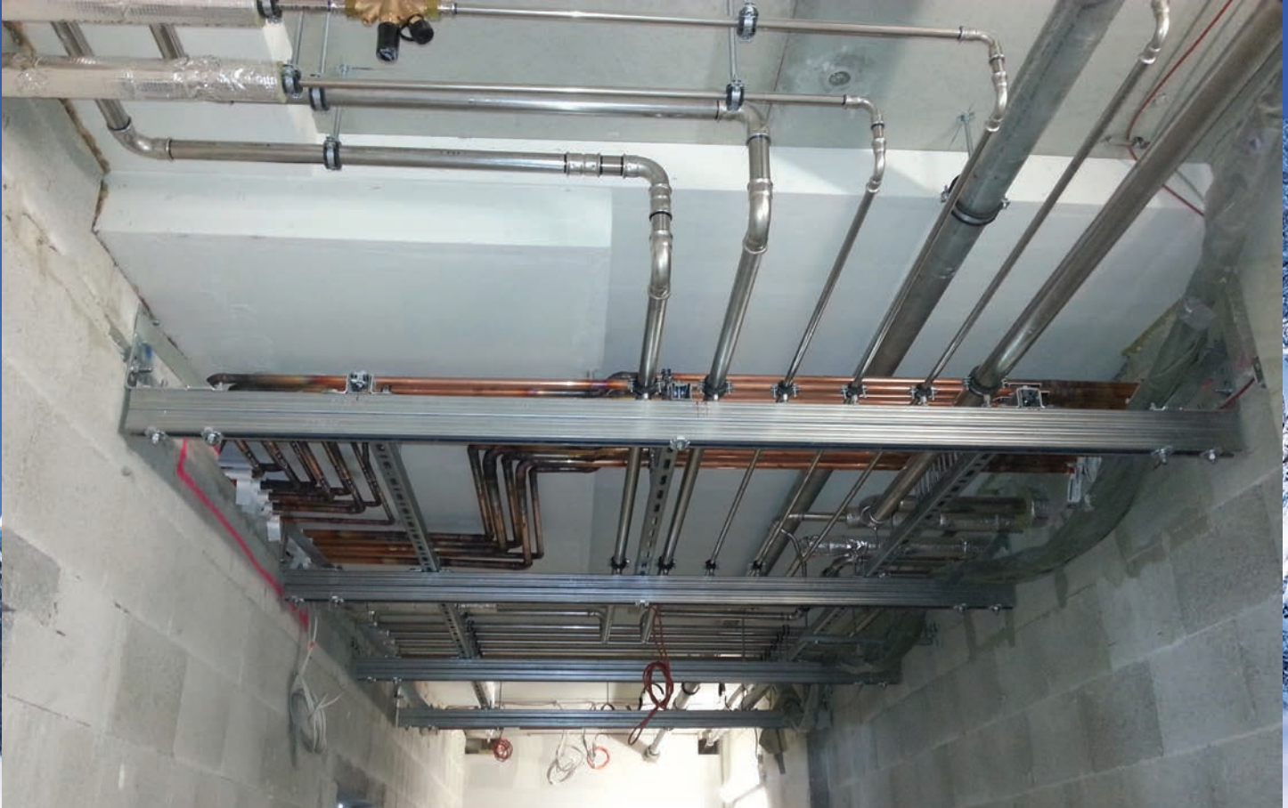
Quertraverse für Heizungsleitungen Montageschienen System 45/90
