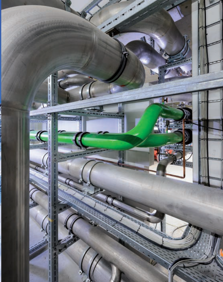
Kühlwasserleitungen CENTUM® Schwerlastsystem mit Anbauteilen
