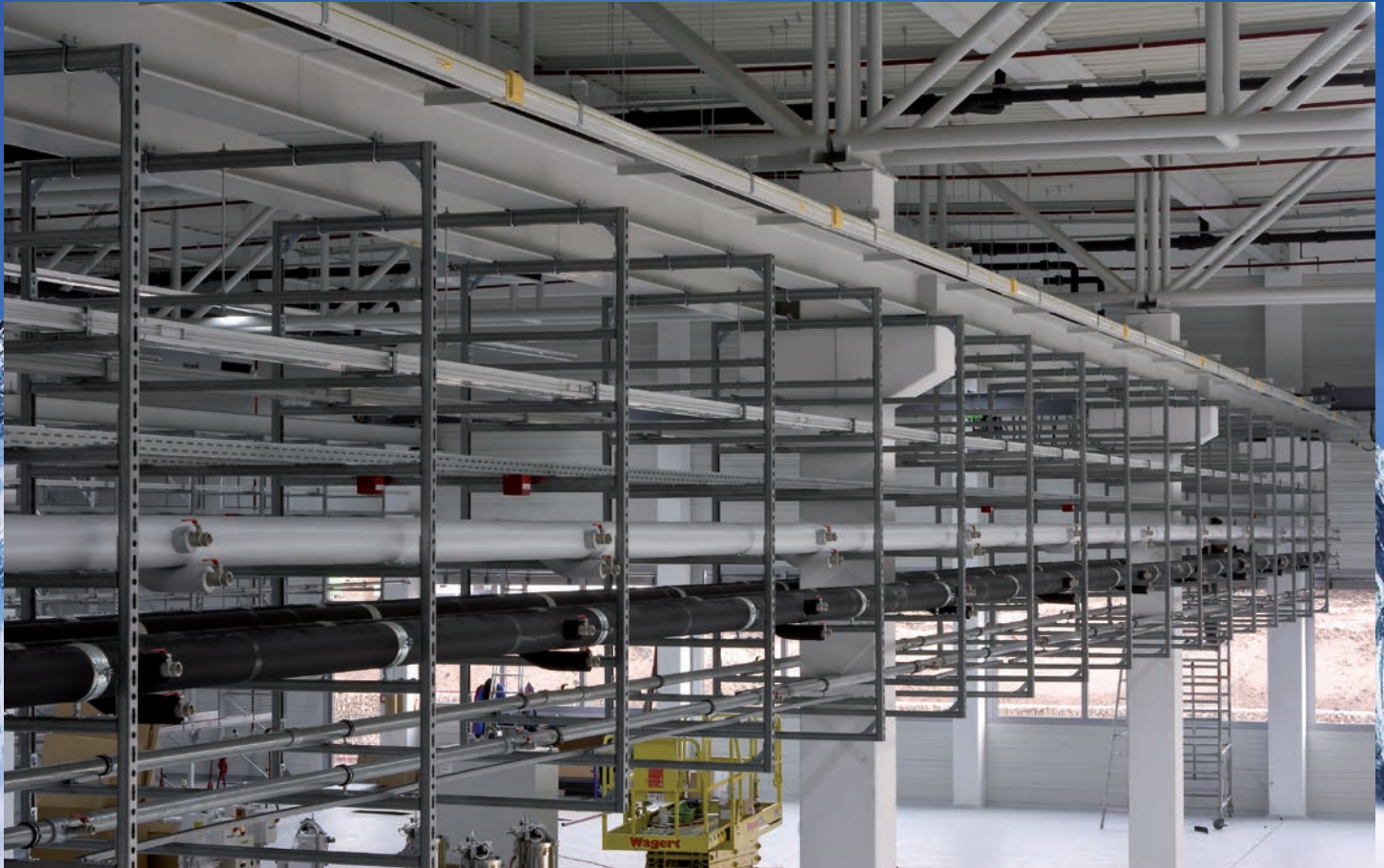
Abhängung an Stahlträgerkonstruktion Montageschienen System 45 mit Verbindungsbauteilen
