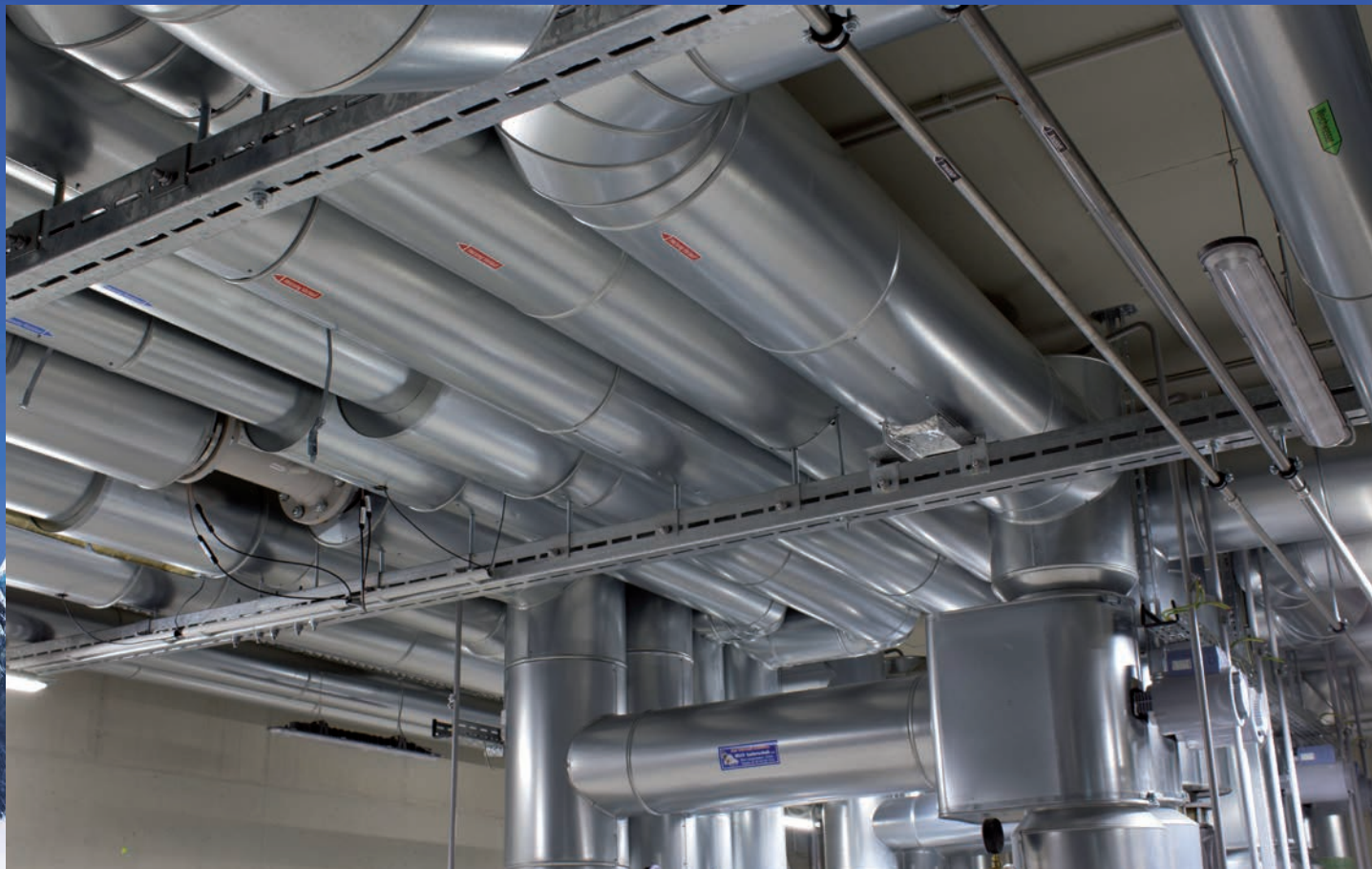
Deckenbefestigung für Heizungsrohrleitungen CENTUM®Schwerlastsystem
