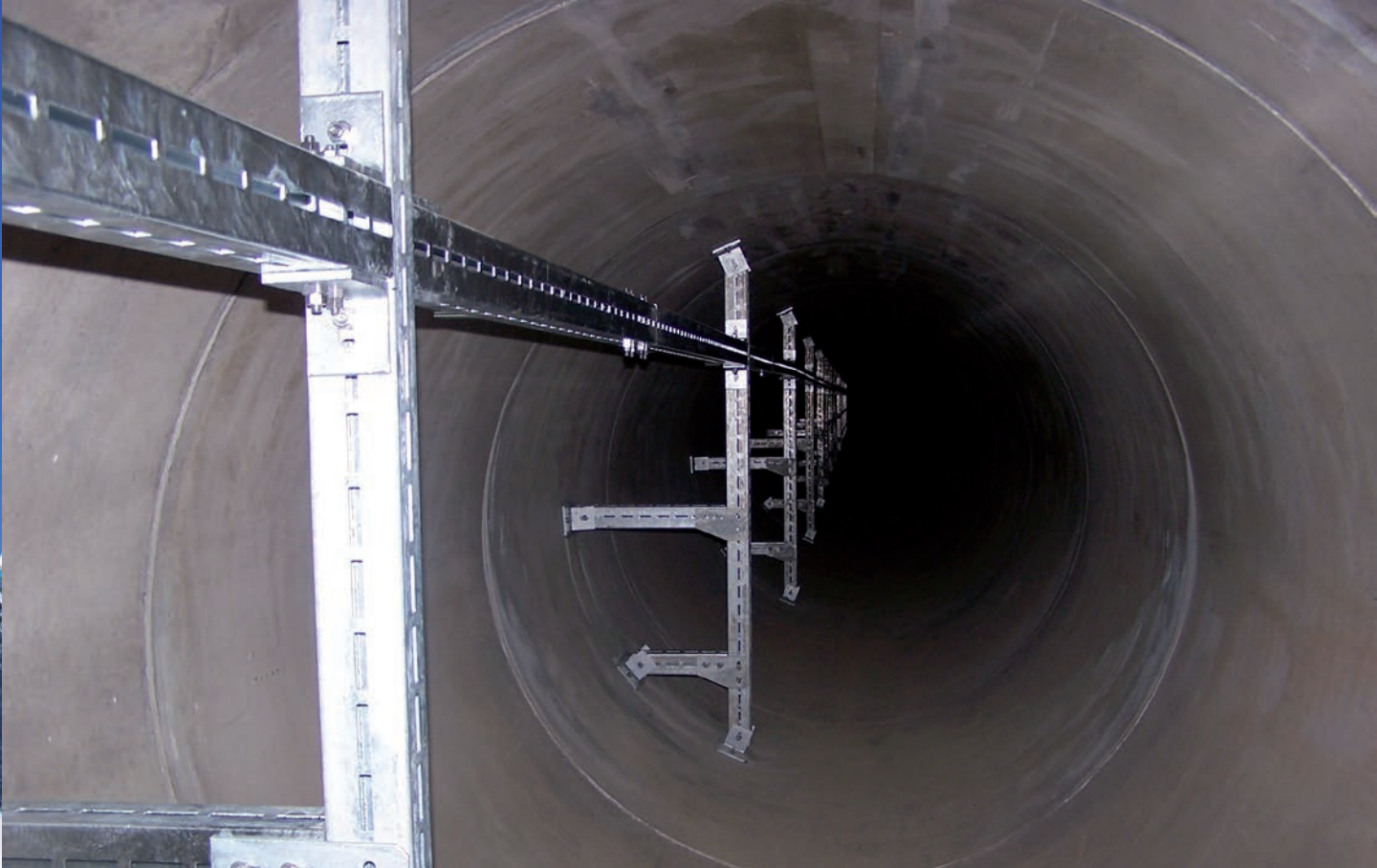
Haltekonstruktionen an runder Tunnelwand Schwerlastsystem CENTUM® XL 100
