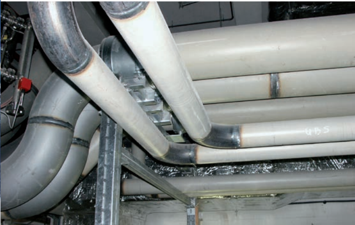
Kälteleitungen CENTUM® Schwerlastsystem mit Kältegleitschlitten
