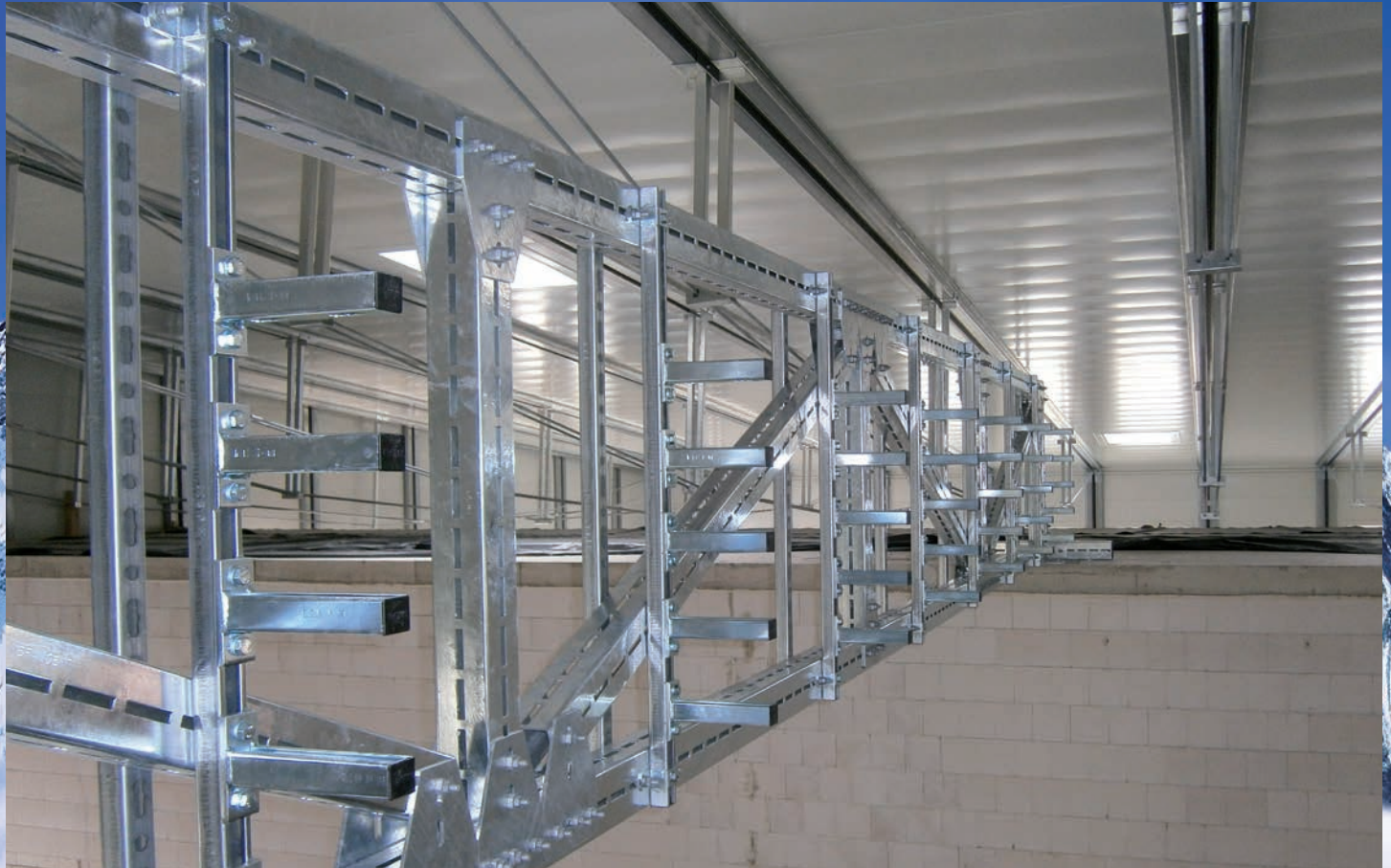
Produktionshalle Lebensmitteleautomaten Montageprofil CENTUM® XL 100 mit Montageschienen System 45
