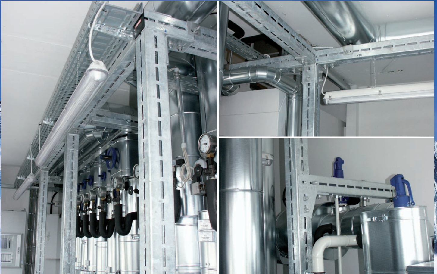
Technikraum CENTUM® Schwerlastsystem mit Anbauteilen
