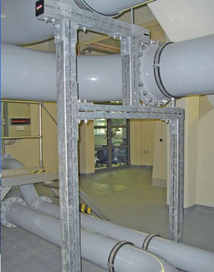
Wasserversorgungsleitung CENTUM® System mit Titan HD Rohrschellen
