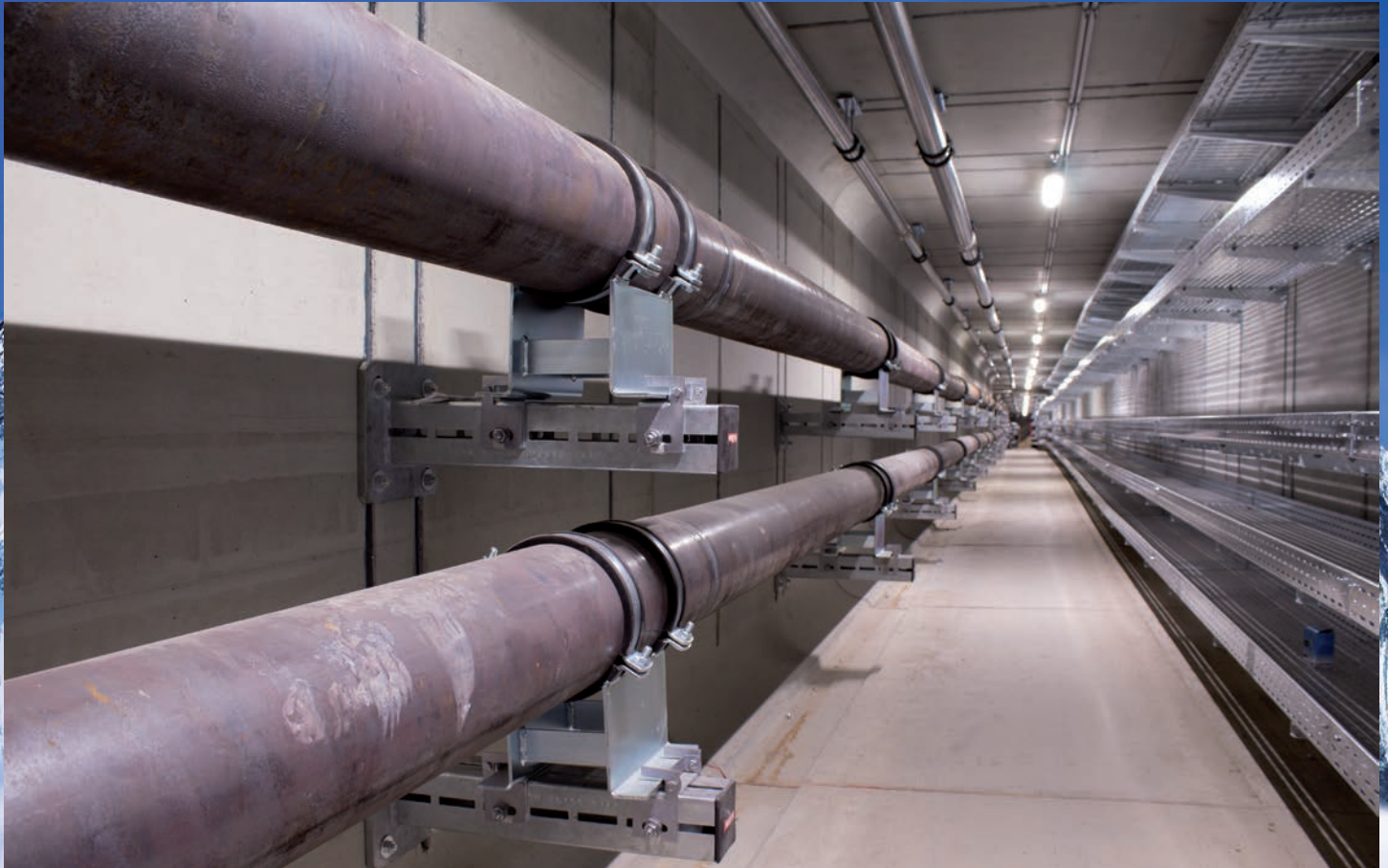
Heizungstrasse gleitend gelagert CENTUM® Wandkonsolen mit Schwerlast Gleitschlitten
