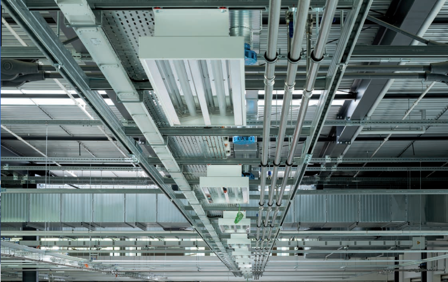
Schienenraster für Deckenrohrmontage Montageschienen System 45 und CENTUM®
