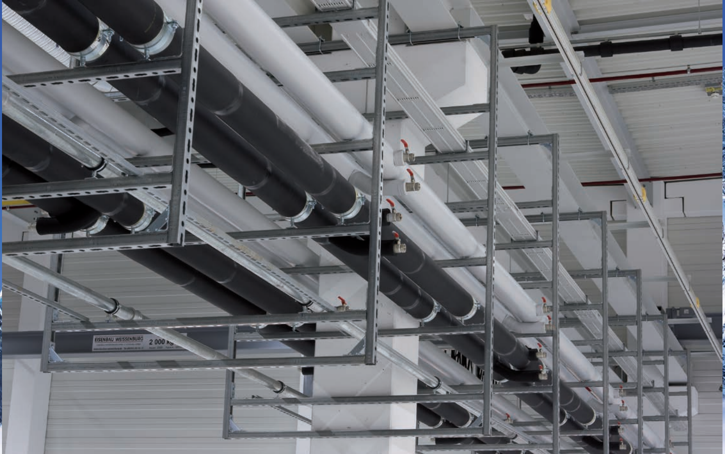
Abhängung an Stahlträgerkonstruktion Montageschienen System 45 mit Verbindungsbauteilen
