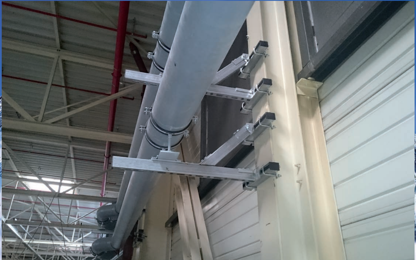
Konsolenbefestigung mit Strebe an senkrechtem Stahlträger Montagesystem 45 mit Titan HD Rohrschelle und Gleitplatten
