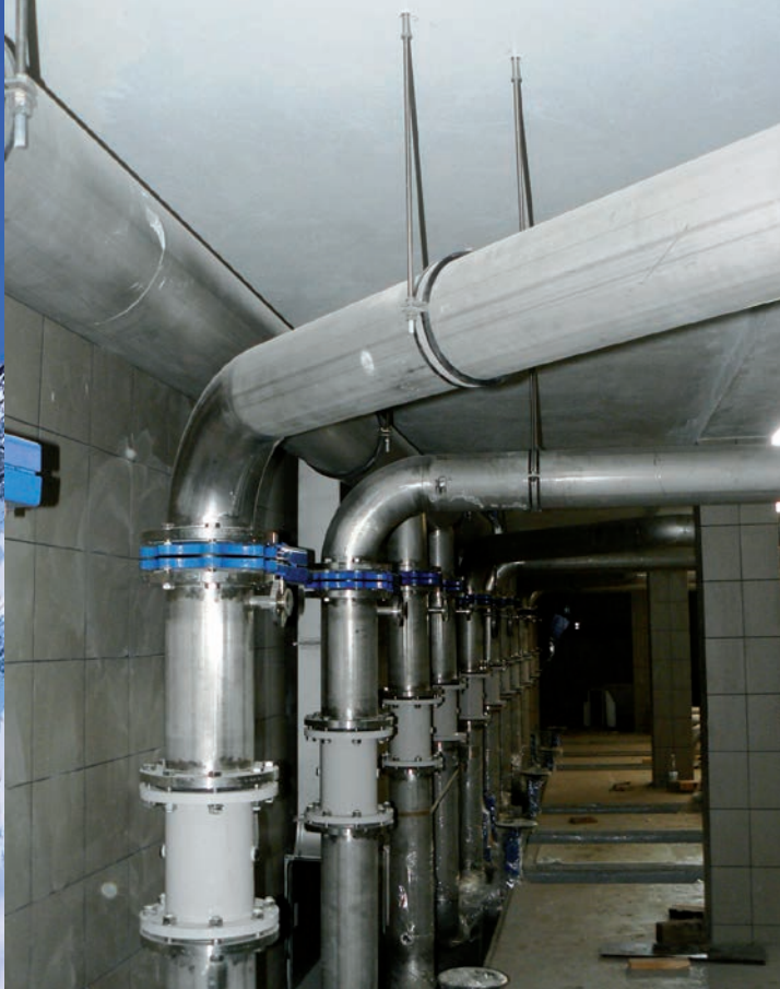
Kühlwasserleitungen Schwerlastrohrschele Titan HD, Abhängung an seitlichen Verschlussflanschen
