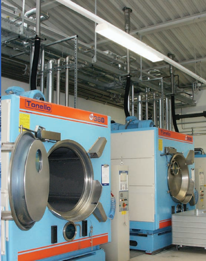
Versorgungsleitung für Wäscherei Montageschienen System 45 in Edelstahl mit Anbauteilen
